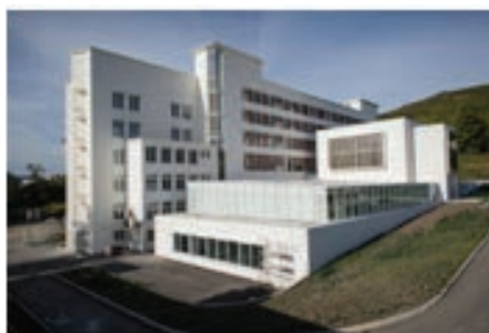
École nationale supérieure d'architecture Clermont-Ferrand. Architectes réhabilitation : Du Besset-Lyon. Photo Pascal Aimar 2015
