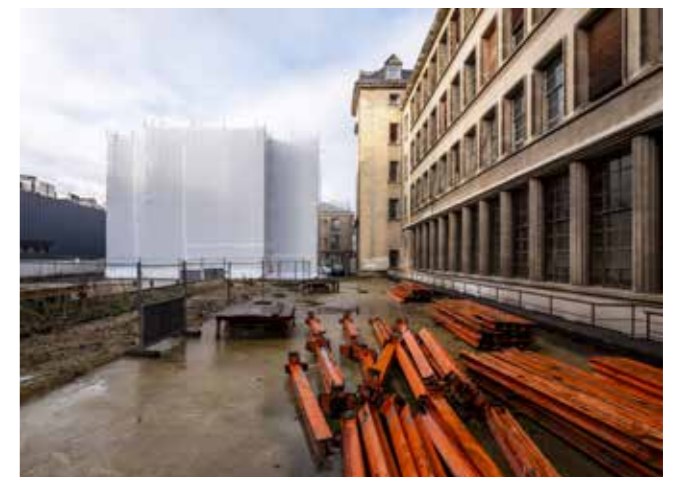
● Siège de l'Oppic, avenue du Maine, Paris
