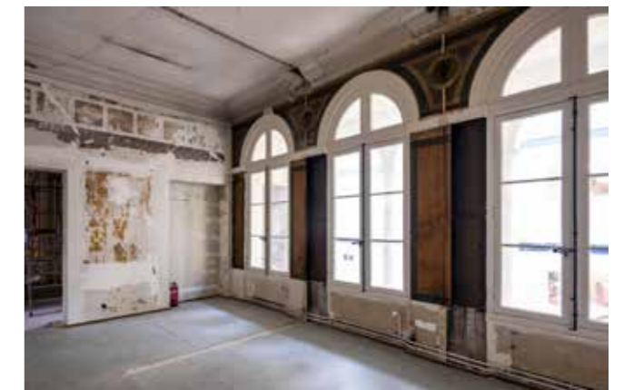
● Siège de l'Oppic, avenue du Maine, Paris
