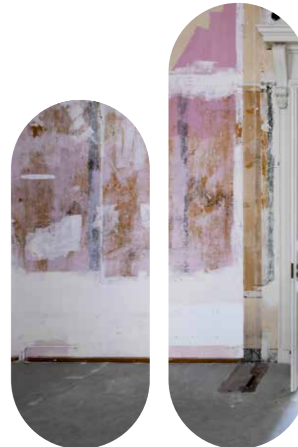
● Siège de l'Oppic, avenue du Maine, Paris
