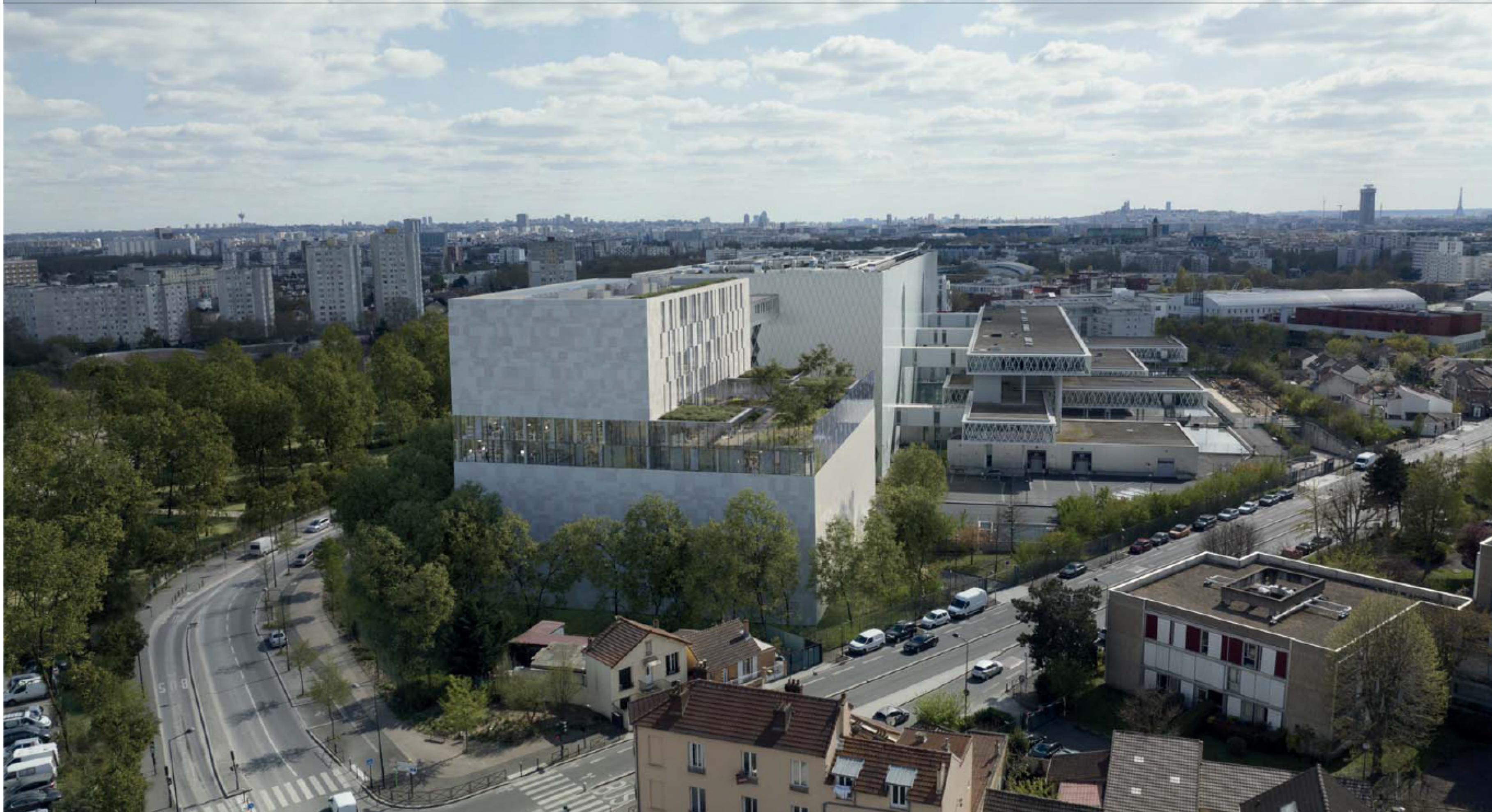
1 - VUE AERIENNE DEPUIS LE CARREFOUR ENTRE L'AVENUE EMILE ZOLA ET LA RUE TOUSSAINT LOUVERTURE
