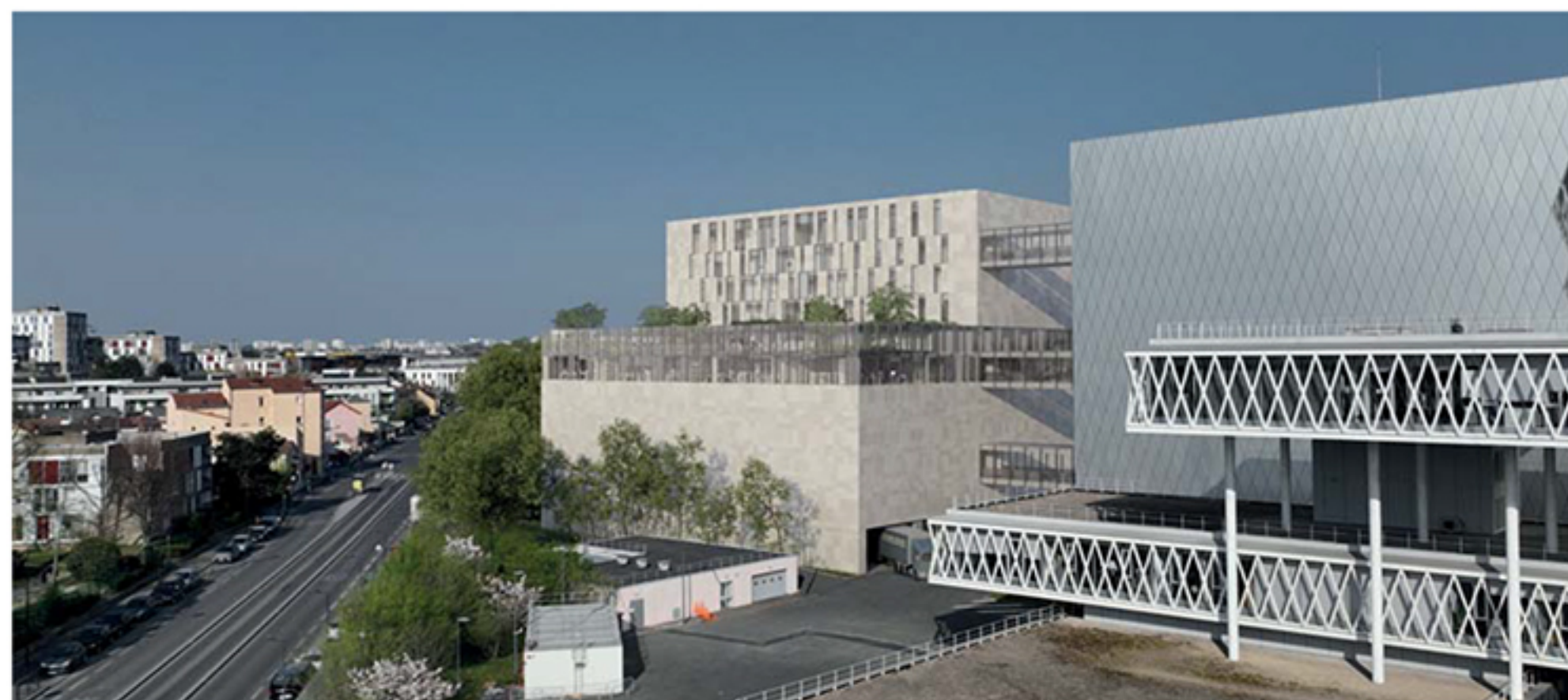
5 - VUE AERIENNE FACE A L'AIRE DE LIVRAISON
