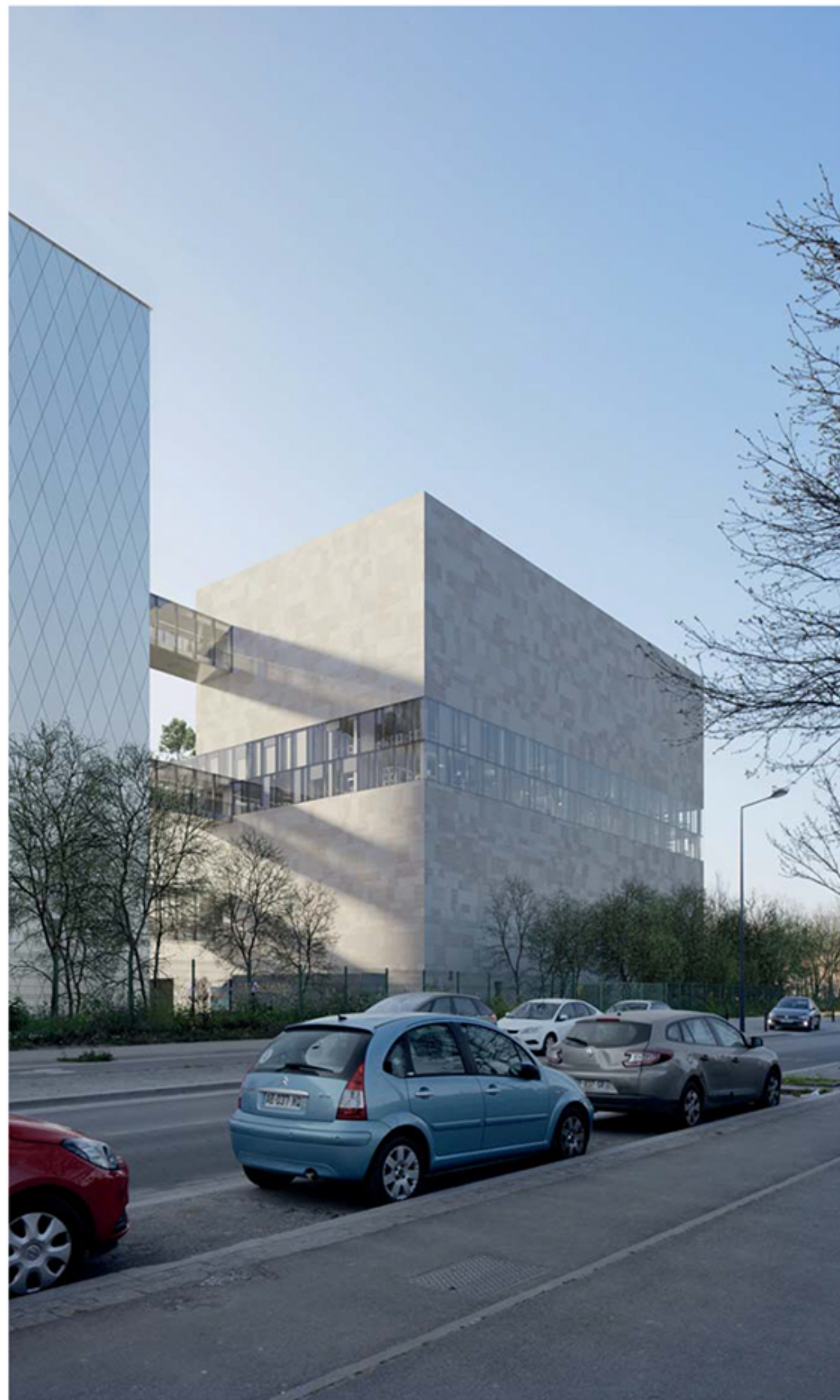
3 - VUE DEPUIS LA FUTURE ZAC DES TARTRES, RUE TOUSSAINT LOUVETURE
