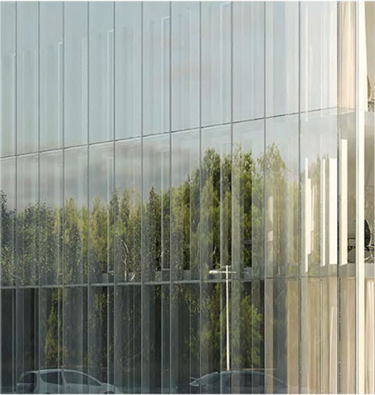
Écran réfléchissant «miroir» en double façade
