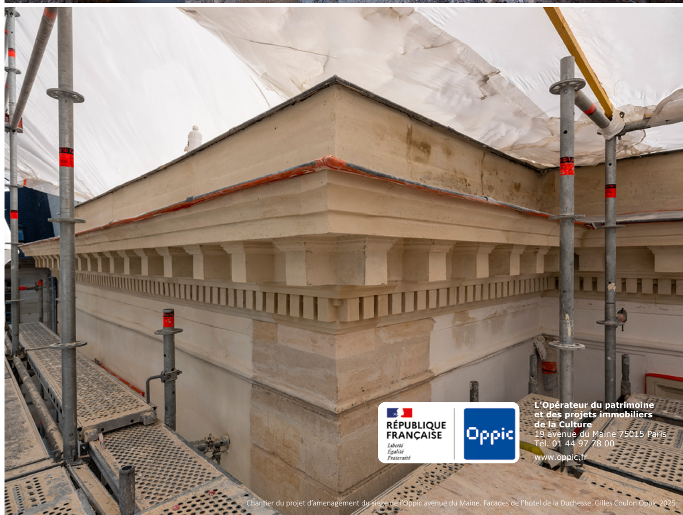
Chantier du projet d'aménagement du siège de l'Oppic avenue du Maine. Fondations de l'extension. Gilles Coulon Oppic 2025
