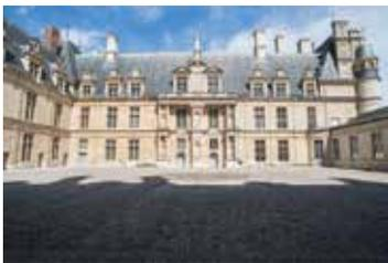
Les travaux ont principalement porté sur le drainage des eaux de pluie, sur le traitement des pathologies de surface ainsi qu'en soubassement des quatre façades et sur la restauration du porche ouest.
